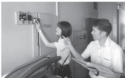
写真-7 省エネ診断の様子
